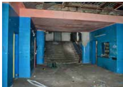
Blaue Fliesen bestimmen einst das Zugangsbauwerk im Bahnhof Wernerwerk.
