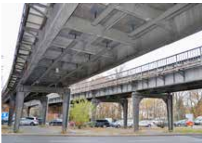
In Höhe des Bahnhofs Wernerwerk kreuzt die zweigleisige Trasse den Siemensdamm.
